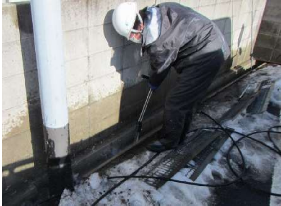
Gambar 27. Contoh dekontaminasi saluran drainase jalan (pembersihan dengan air bertekanan tinggi)
