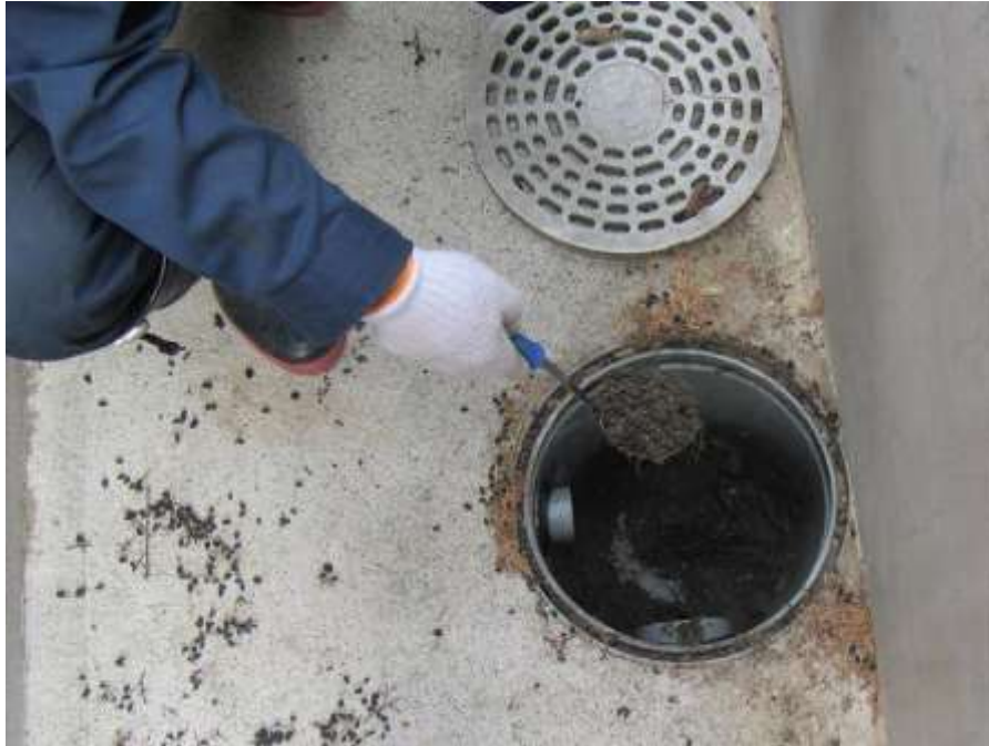
Gambar 25. Contoh dekontaminasi ruang penampungan air hujan (pengangkatan sedimen)
