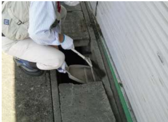
Gambar 43. Contoh dekontaminasi saluran drainase jalan (membersihkan kotoran dan debu
