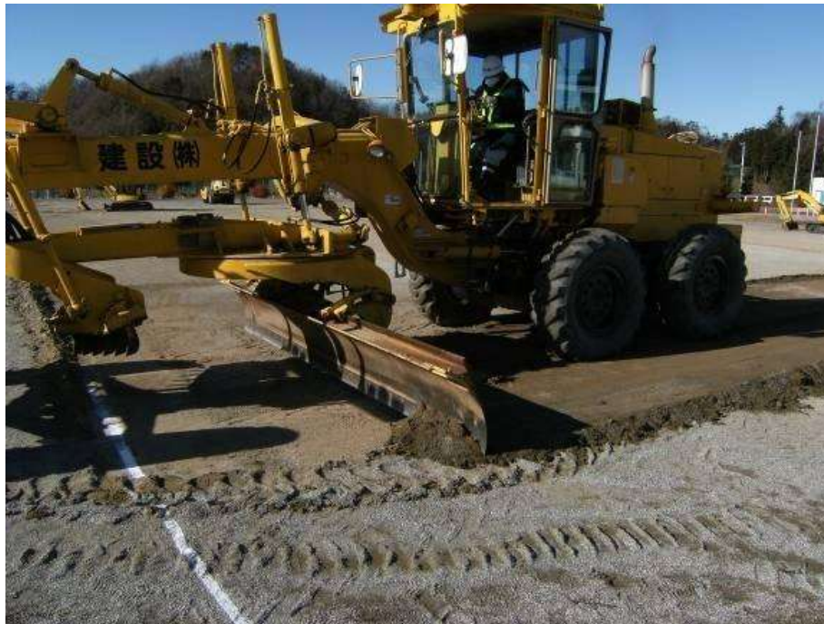
Gambar 52. Contoh proses dekontaminasi lapangan sekolah (pengikisan lapisan tanah atas)
