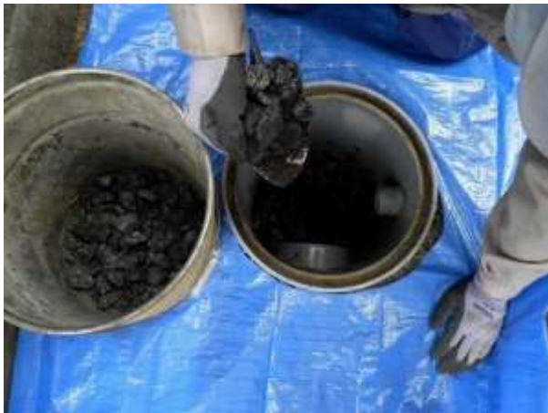
Gambar 26. Contoh proses dekontaminasi ruang penampungan air hujan (pembuangan sedimen dan pengolahan sedimen ruang penampungan air hujan secara mendalam di lokasi yang sama)
