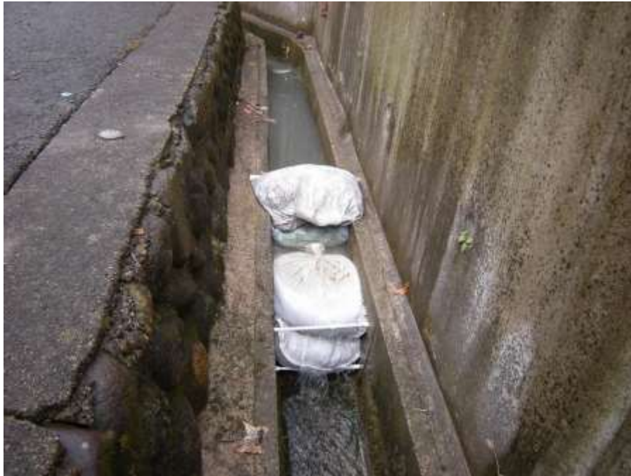
Gambar 32. Contoh pengolahan air limbah (kantong pasir yang dipasang di saluran drainase jalan)
