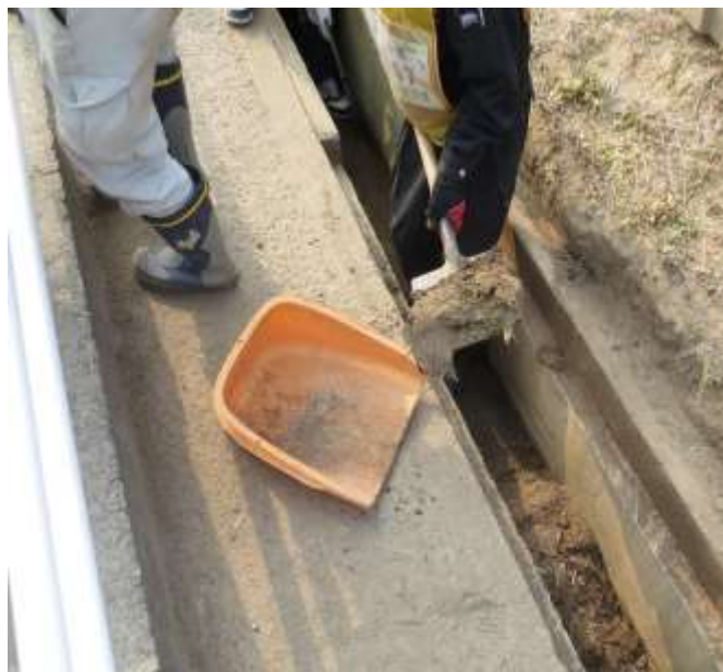
Gambar 44. Contoh dekontaminasi saluran drainase jalan (pengangkatan sedimen
