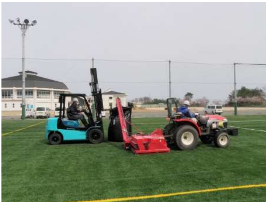
Gambar 53. Contoh pengangkatan material pengisi dari rumput sintetis
