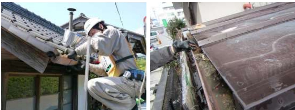
Gambar 13. Contoh dekontaminasi saluran air hujan (pembersihan dengan lap) (foto courtesy Kota Date dan Kota Fukushima)
