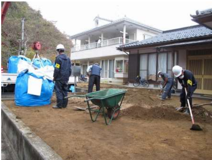
Gambar 22. Contoh dekontaminasi taman dan area lain (pembuangan tanah, dll)
