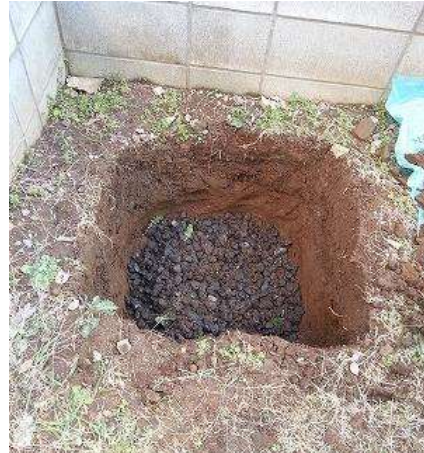
Gambar 26. Contoh proses dekontaminasi ruang penampungan air hujan (pembuangan sedimen dan pengolahan sedimen ruang penampungan air hujan secara mendalam di lokasi yang sama)
