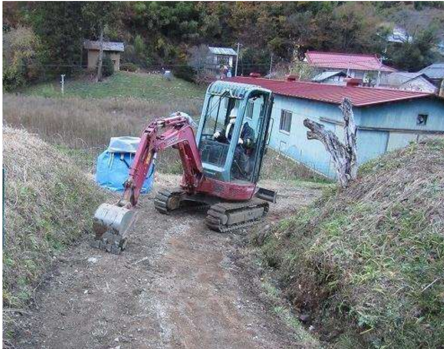
Gambar 41. Contoh dekontaminasi jalan tak beraspal (pengikisan)
