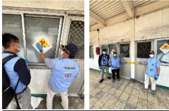
Gambar 17. Pemasangan Tanda Bahaya Radiasi dan Tali Kuning di Ruang Penyimpanan Limbah
